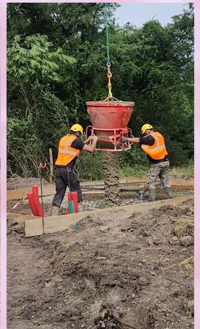
Moins de 10 secondes pour décrocher et accrocher le godet spécial hélico et hop ! le pilote repart en direction de sa zone de dépôt où une équipe l'attend pour couler l'énorme socle ayant nécessité 40m<sup>3</sup> de béton !
