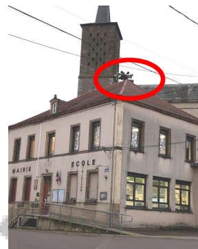
La sirène est située sur le toit de la mairie
