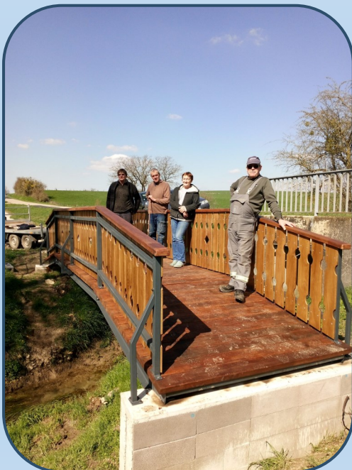
L' équipe posant sur la passerelle achevée.
