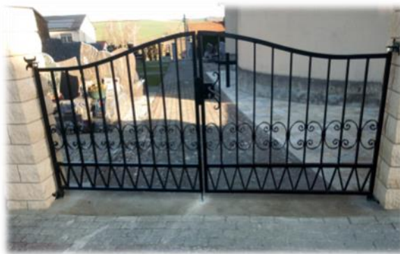
Installation du portail agrandi, regalvanisé, repeint et nouveau seuil en béton
