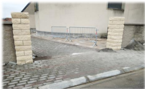
Création des poteaux et pose des pavés
