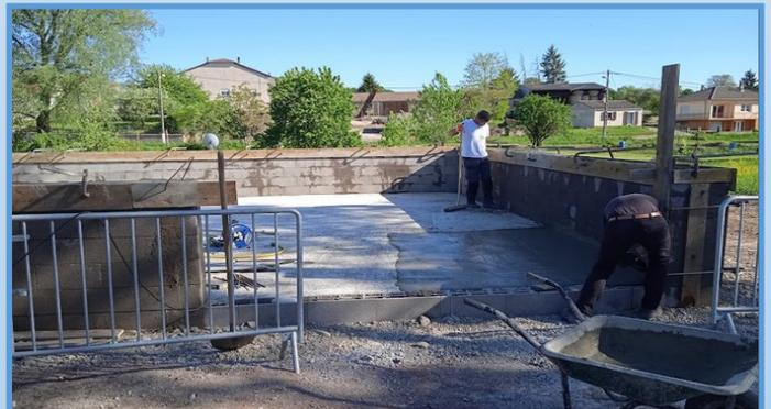
En haut à gauche : les fondations ont été creusées puis coulées. En haut à droite : les murs ont été montés par des bénévoles que nous ne saurions trop remercier ! En bas, à gauche : un camion toupie a acheminé le béton nécessaire à la création de la dalle. En bas à droite : pour finir, les parpaings ont été crépis en attendant l'installation des murs hauts.
