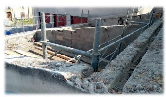
De gauche à droite et de haut en bas : la chaufferie « avant » ; démontage de la toiture ; rehausse des murs en parpaings et résultat final !
